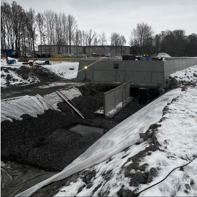
Noden montage av L-stöd för kommande trallyta.
