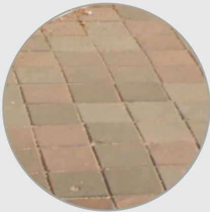
Betongplattor på gångyta längs med norra torngatan.
