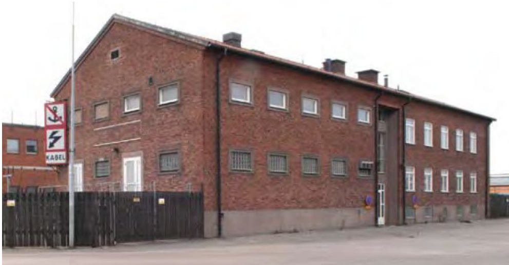
Transformatorstationsbyggnad på fastigheten Städet 11. (Foto Sven-Olof Ahlberg)
