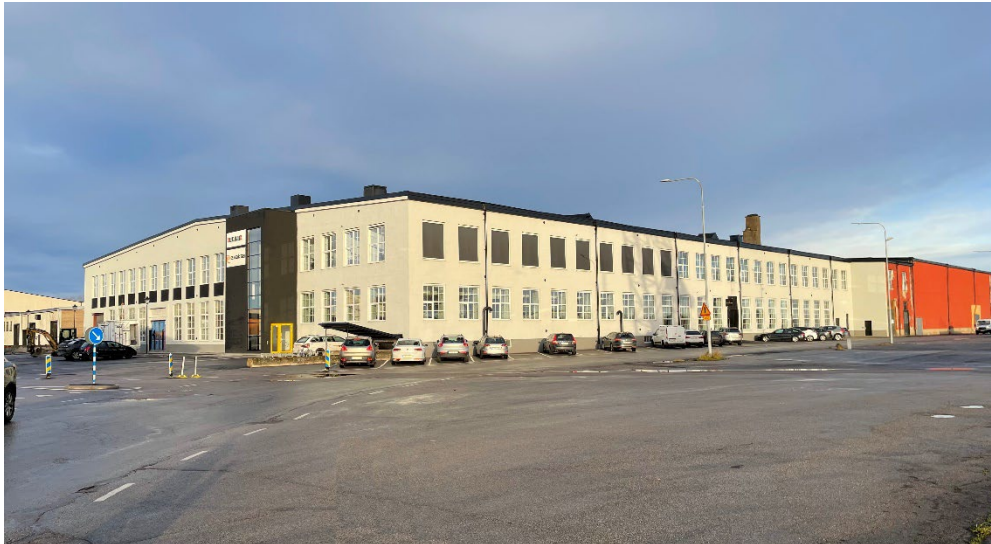
Gjuteriet på fastigheten Städet 16.
